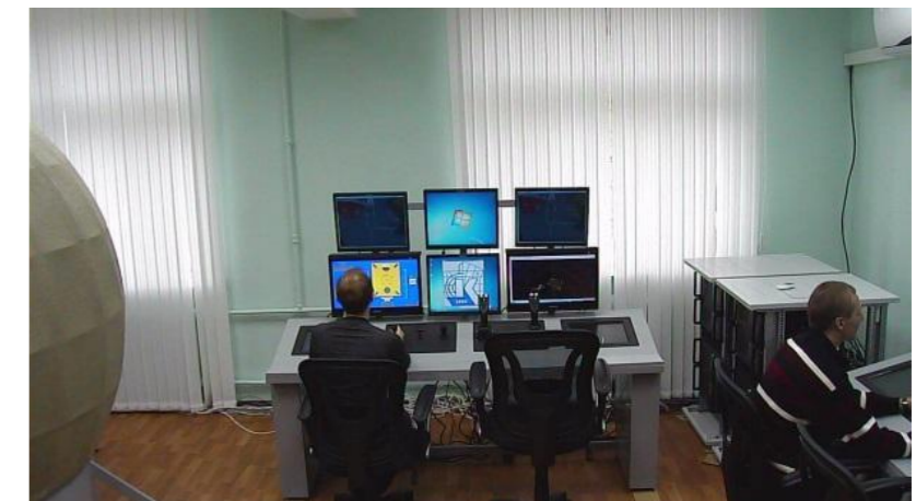
АРМ операторов мониторингового телеуправляемого ПА
